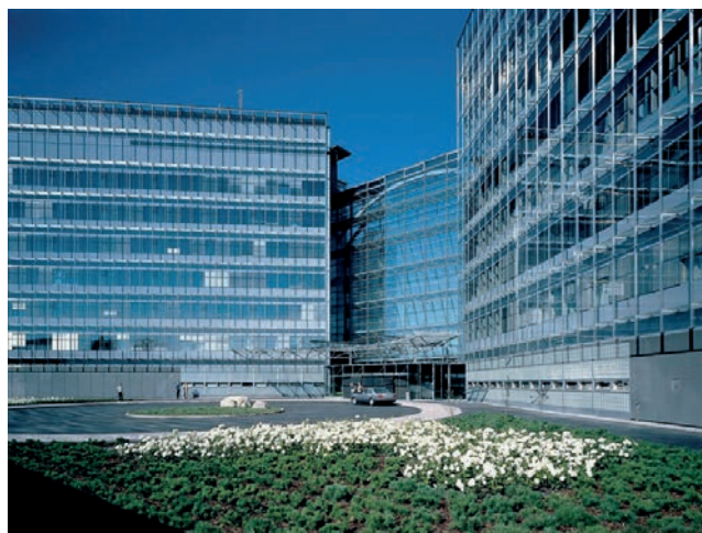
Ensimmäisen kerran palkinto jaettiin vuonna 1997 Espoon Keilaniemeen valmistuneen Nokia-talon kaksoisjulkisivuratkaisulle.
