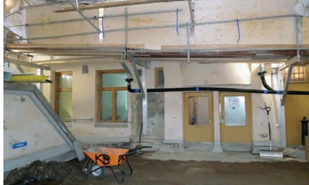
Sisäpihaa ja pihakansia on saneerattu sääsuojan alla.
