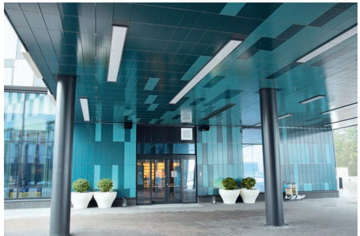
Julkisivukeramiikka Keratwin K20 ja K15 (ABL-Laatat).
