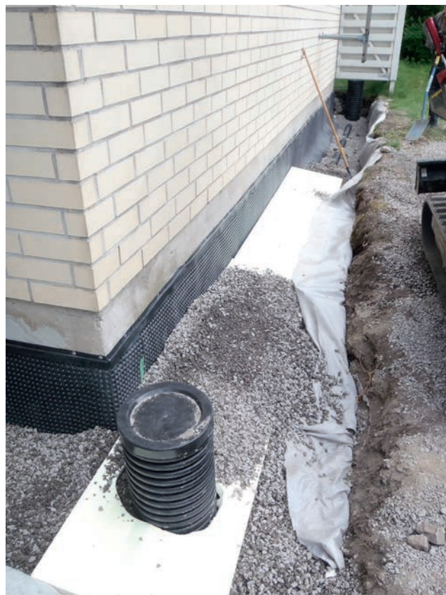
Talon ulkopuolen vesieristys ja salaojien korjaus.
