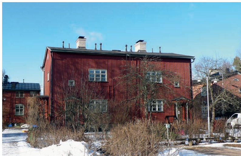
Sampsantie 38:n kattoremontti alkaa kesällä 2017.
