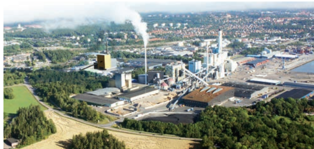
Uusi voimalaitosblokki 7 näkyy kuvassa vasemmalla.
