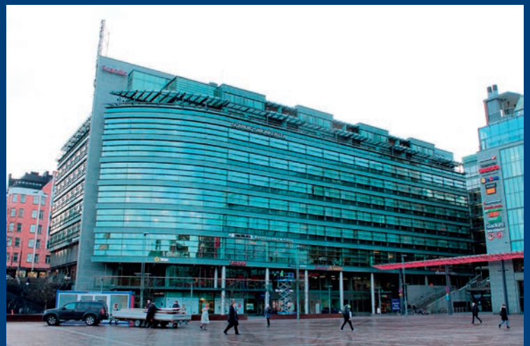
Scandic Simonkenttä. Hotellirakennus yli 360 huonetta ja isot liiketilat. RePipe on suorittanut työn erikoismenetelmällä.
