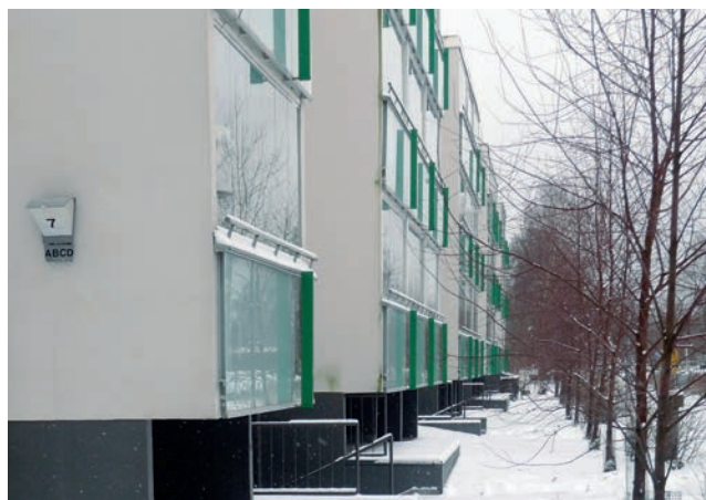
Ryhmäkorjaushanke laajenee alkukesällä 2018 viereisen taloyhtiön kerrostaloihin Yliskyläntie 7:ssä.
