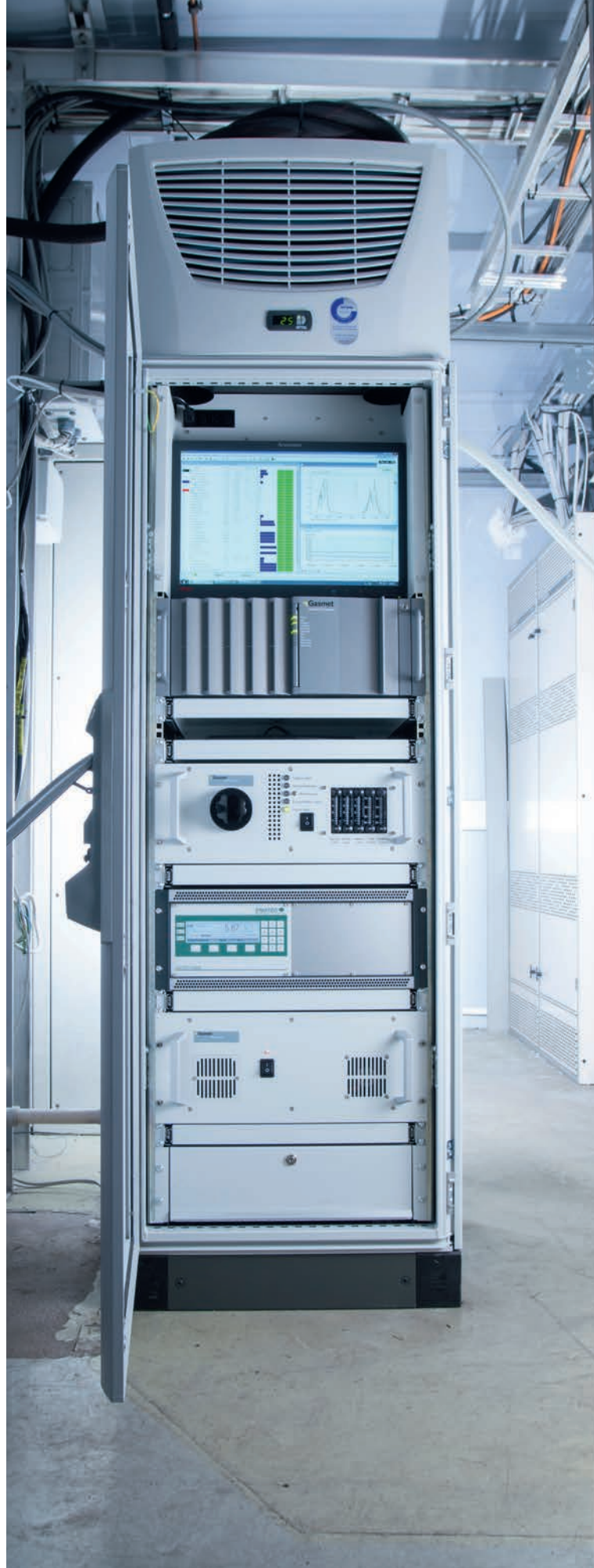
Suomessa käytettyjen päästömittausjärjestelmien tulee olla sertifioituja, eivätkä viat siksi ole kovin yleisiä. Kuvassa Gasmeter CEMS II e -päästömittausjärjestelmä, jolla on pitkä kuuden kuukauden huoltoväli.
