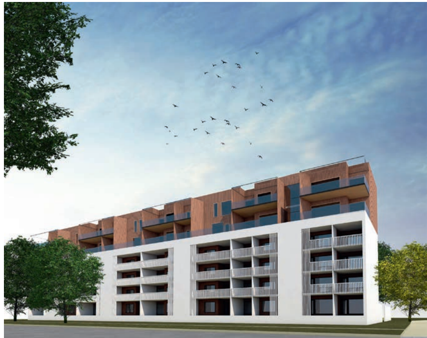
Juha Riihelän palkittu ehdotus "Latvus". Latvuksen näyttävät lisäkerrosten puujulkisivut on tehty CLT-tilaelementeistä.
