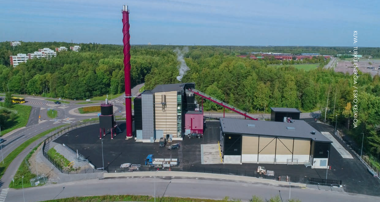
Artukaisten alueelle rakennettu höyryntuotantolaitos.
