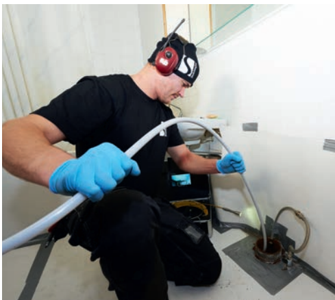
Viemärin puhdistus meneillään.
