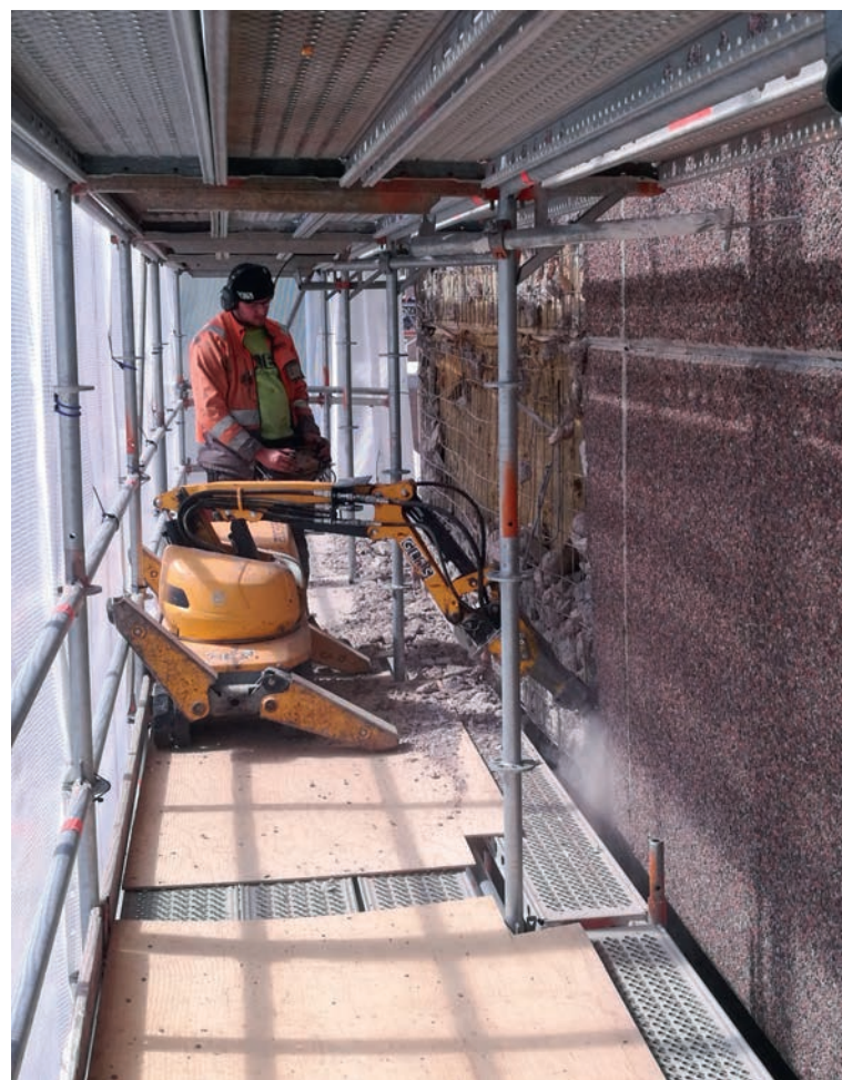
Ulkokuorielementtien purkaminen onnistuu talvella myös sääsuojan sisällä.
