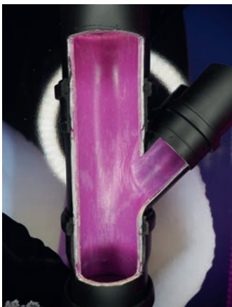
Myös putkien haarakohdat sukitetaan.
