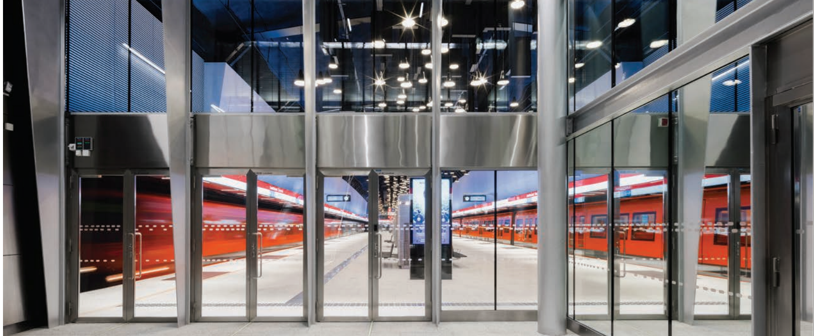
Vitrean SGG Contraflam Structure palonsuojalasit Lauttasaaren metroasemalla.
