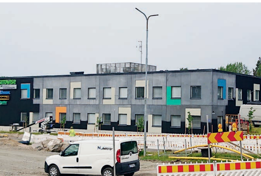
Jyväskylässä harmaasävyisestä väribetonista saatiin musta käsittelemällä toimistorakennus kuultoväriellä Faceal Color, Basic Black. Samalla tuotteella saatiin suojaa liikenteen likaa ja vettä vastaan.
