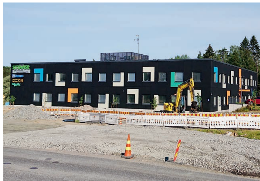
Jyväskylässä harmaasävyisestä väribetonista saatiin musta käsittelemällä toimistorakennus kuultoväriellä Faceal Color, Basic Black. Samalla tuotteella saatiin suojaa liikenteen likaa ja vettä vastaan.
