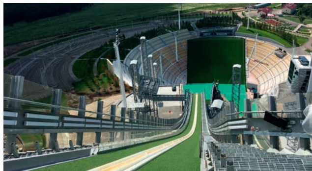
AKKE S-MEASURE järjestelmä valvoo mäkihyppystadionin rakenteita Kazakstanin Shchuchinskissa 24/7.
