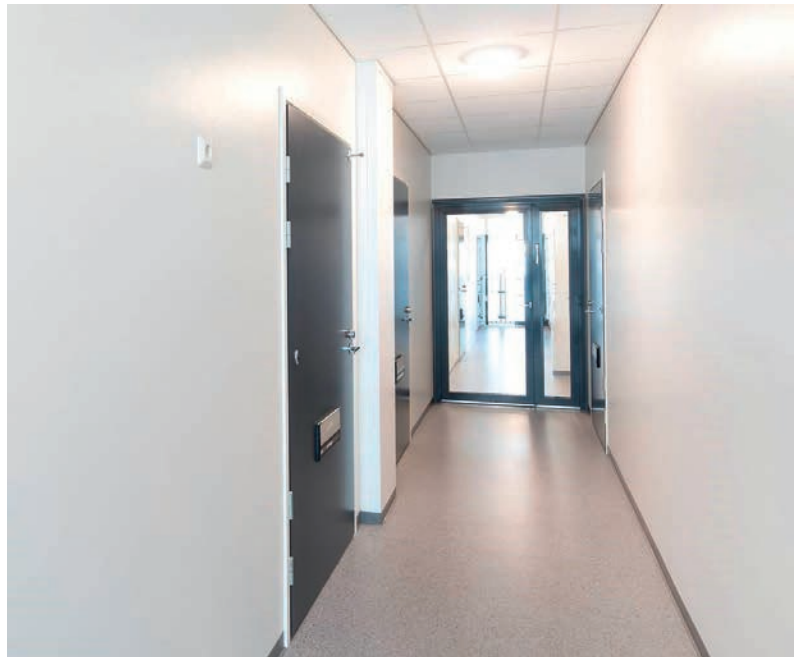
Pipe-Modulin talotekniikkakotelot asennettuna porraskäytävään.
