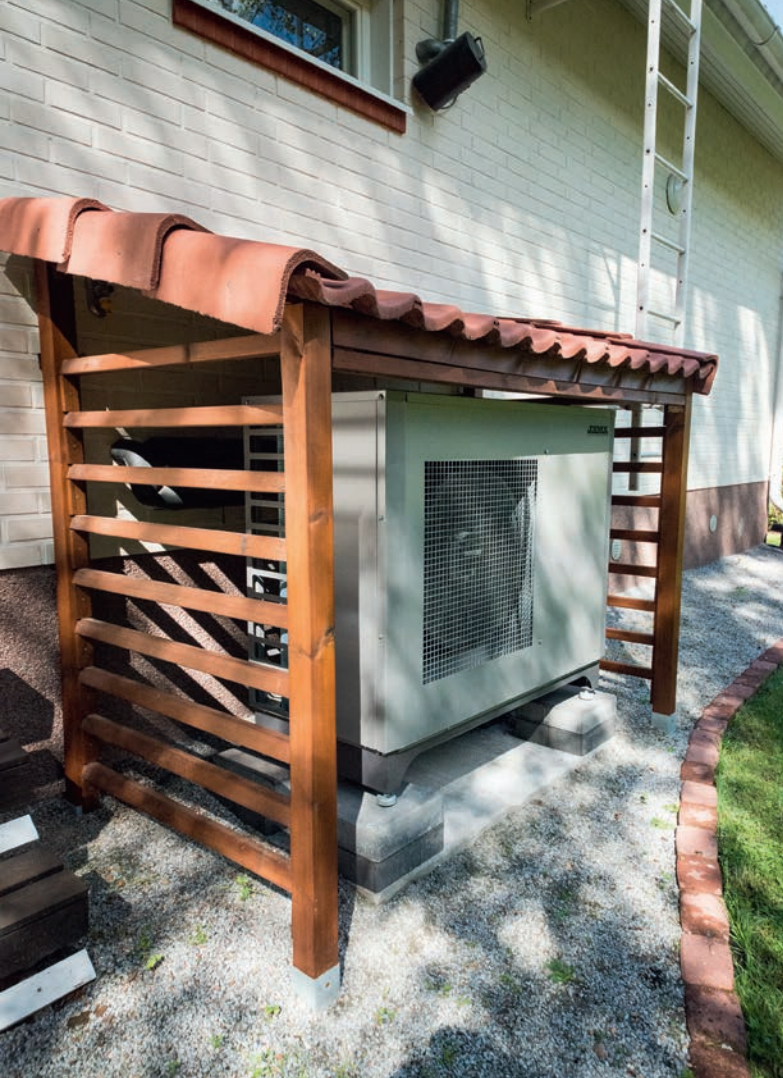
Ilma-vesilämpöpumpulla öljylämmityksen rinnalla saa puolitettua vuotuisen energialaskunsa.
