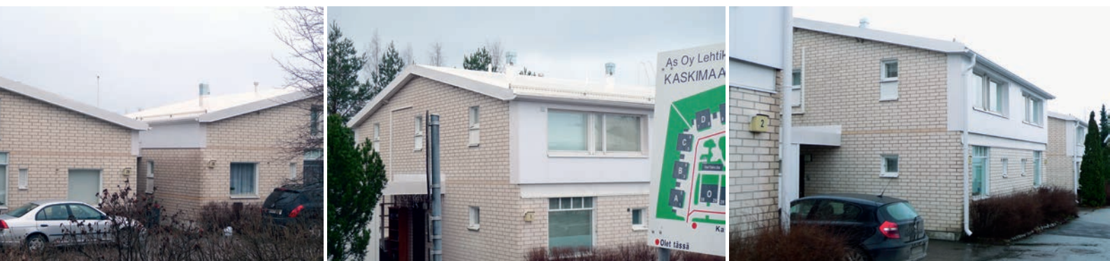
Kaskimaa 2:n vesikatot ja osa julkisivuista korjattiin valkoisella Protan-katteella.
