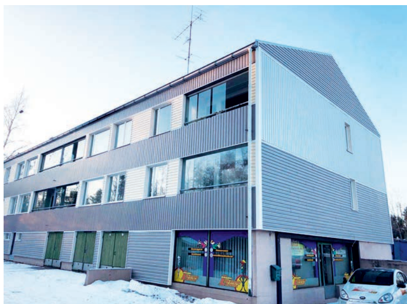
Talo 1 ja 2 Vanha betonielementtitalo lisäeristettiin ja verhoiltiin huoltovapaalla vinyylillä. Kuvapari ennen ja jälkeen verhoilun.
