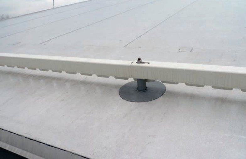
Kattojen reunoille asennettiin uudet lumiesteet.
