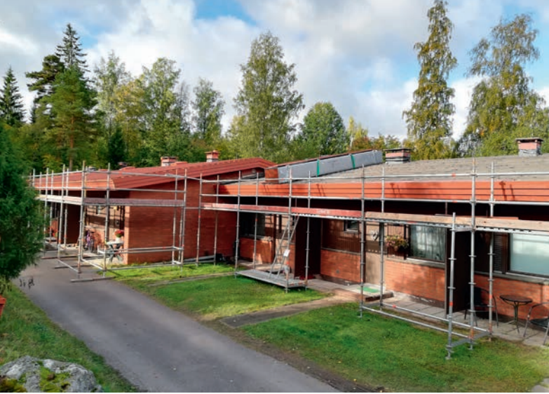
Koko rivitalon ympäri kiertävät rakennustelineet maksimoivat työmaan turvallisuuden As Oy Markkinalehdossa.
