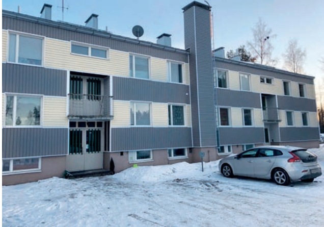
Vanha betonielementtitalo lisäeristettiin ja verhoiltiin huoltovapaalla vinyylillä.
