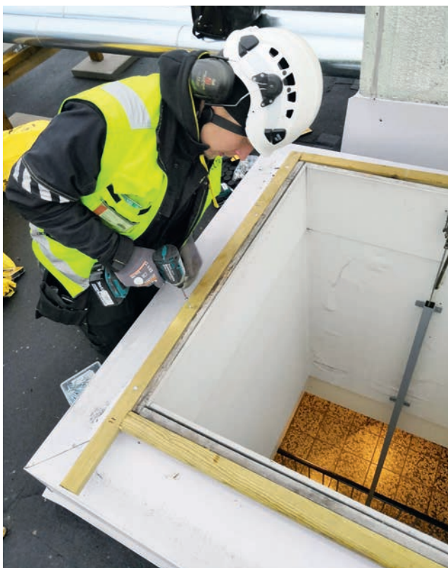
Kuvassa savunpoistoluukun asennus.
