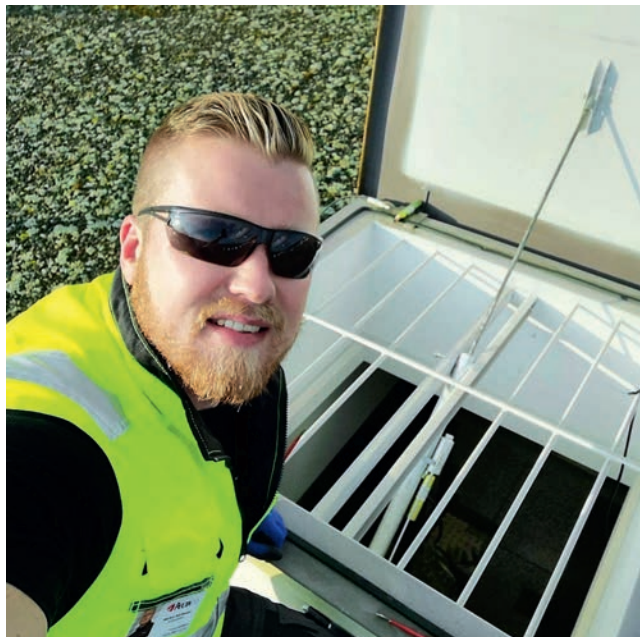
Savunpoistoluukun huolto käynnissä.
