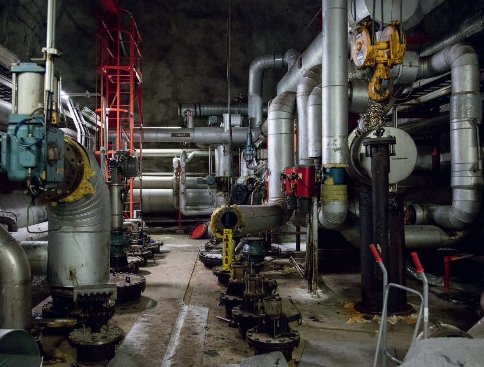
Kuvassa Mustikkamaan vanhat öljyluolat, jonne rakennetaan Suomen suurin lämpövarasto.
