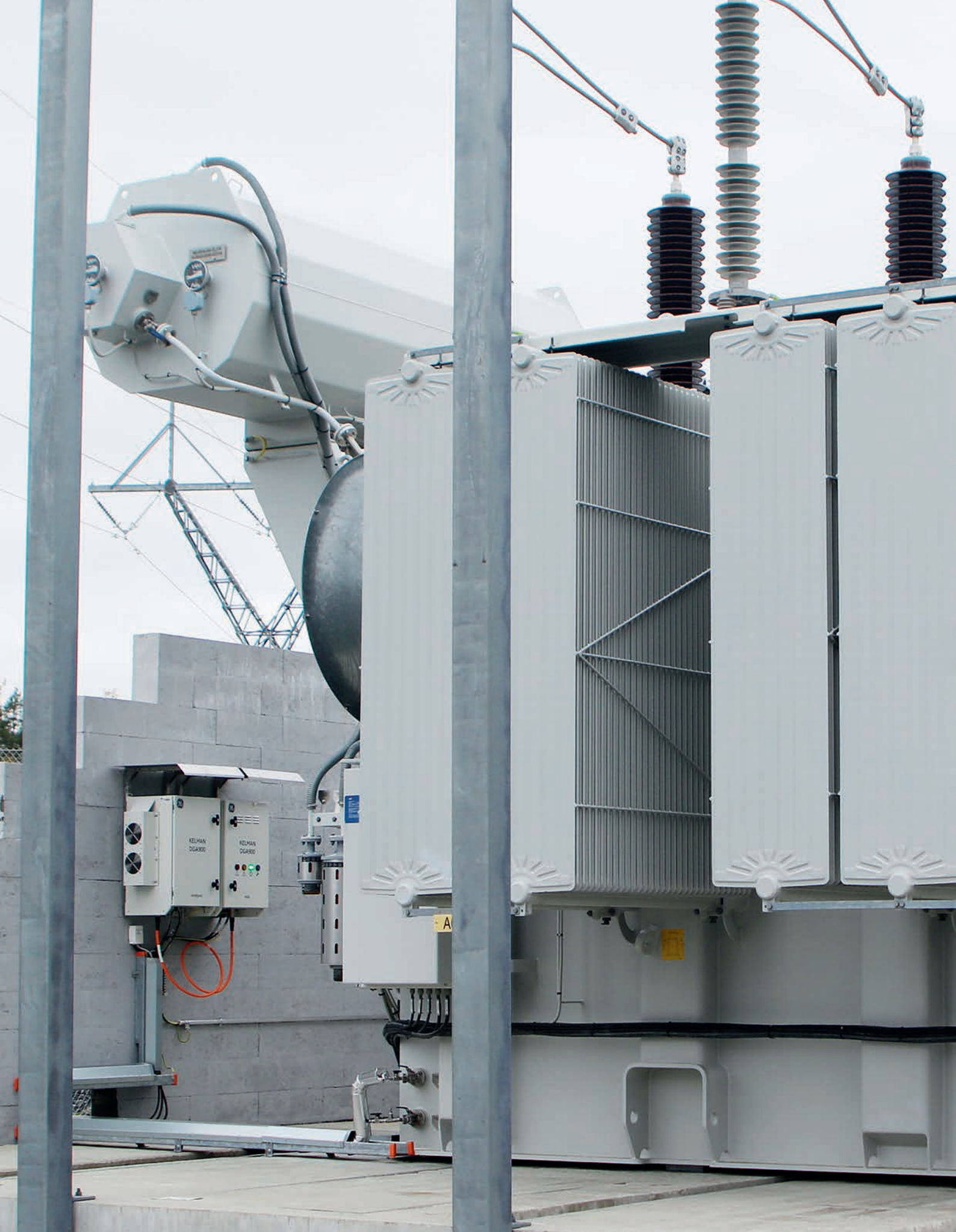
Kelman DGA 900 online-kaasuanalysaattori kytkettynä tehomuuntajaan.
