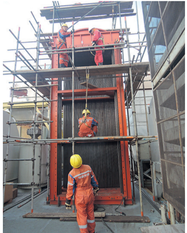
Lämpöputkilämmönsiirtimellä toteutettu höyrykehitin kaasuturbiinin jälkeen.
