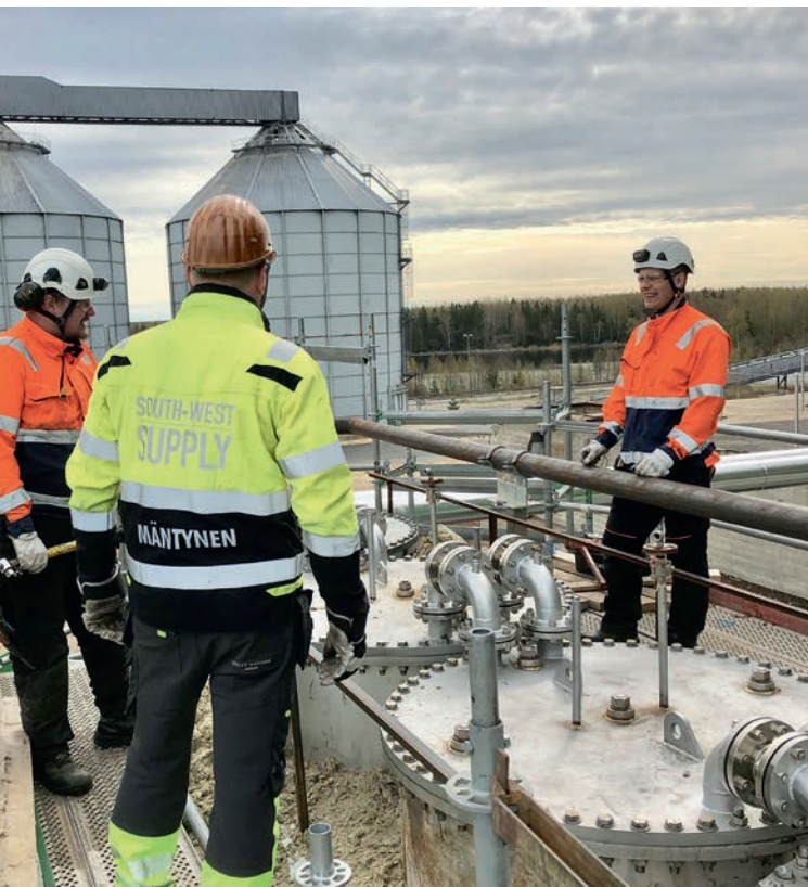
Lämpöputkilämmönsiirtimen asennustyömaa.
