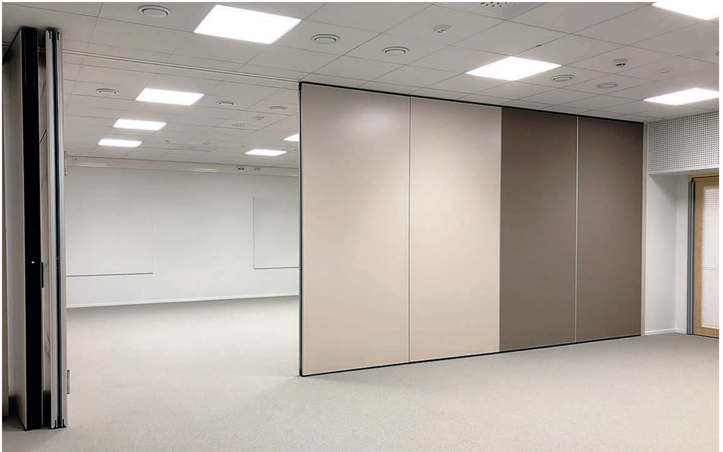
Porvoon Strömborgska Skolan, jossa siirtoseinien elementeissä osittain akustinen neulahuopapinta.
