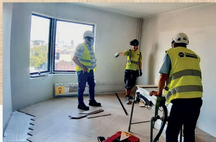
Asennus on hyvässä vauhdissa Hotelli Ilvesen työmaalla.
