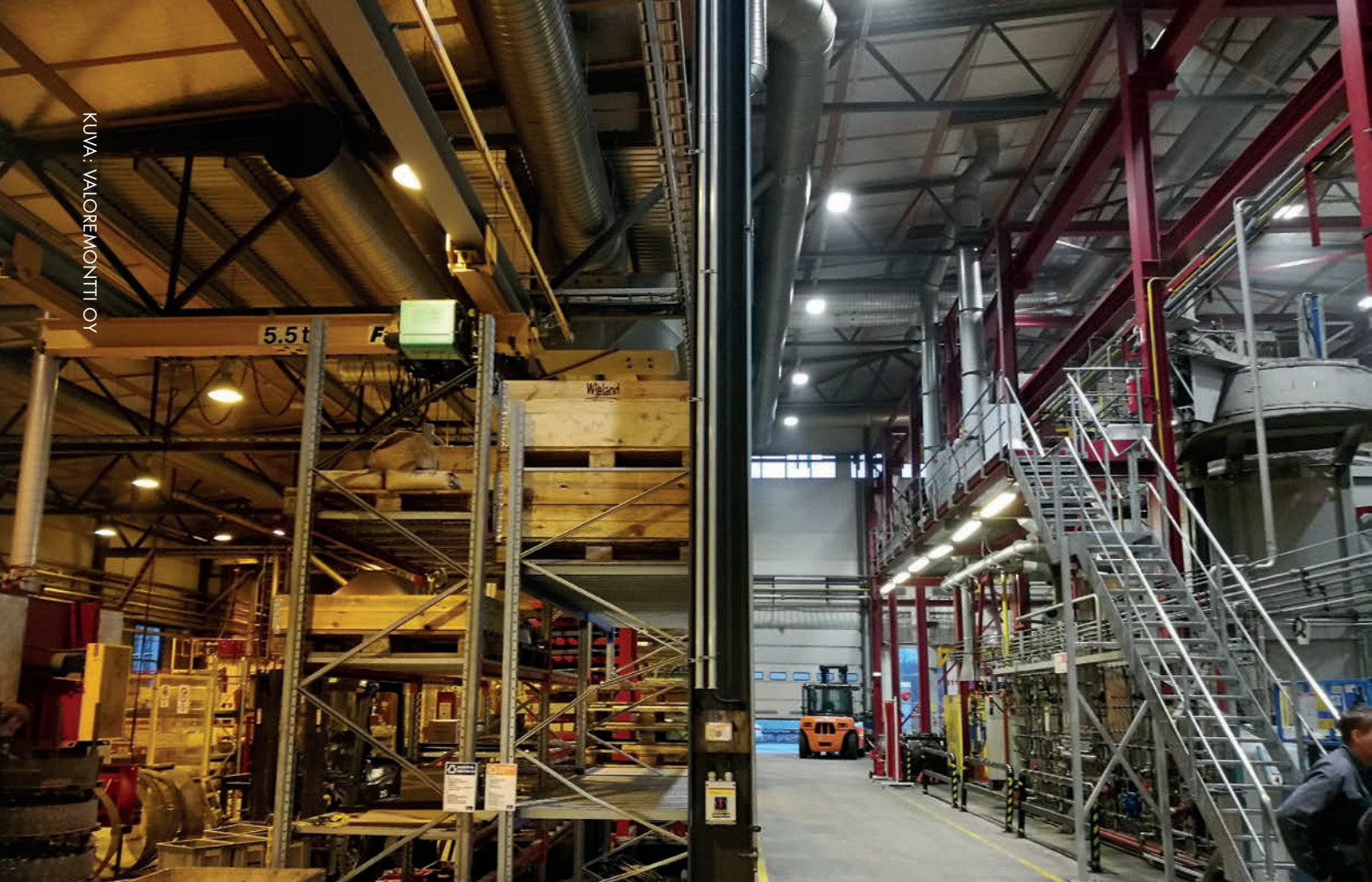
Kuvassa seinän toiselle puolelle oikealle on tehty jo vaihto LED-valaisimiksi ja toisella puolella on vielä suurpainenaatrium valonlähteillä toteutettu valaistus.
