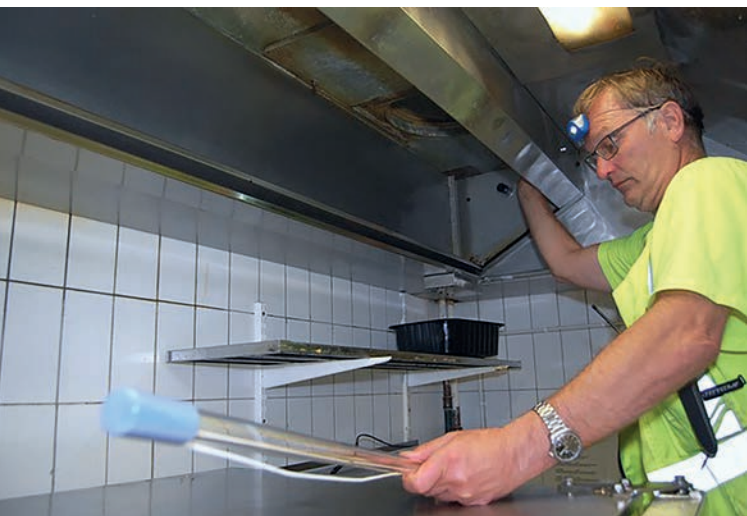
Zaila-otsonaattori tuo ravintolaan paloturvallisuutta, helpottaa ilmanvaihtokanavien puhtaanapitoa ja vähentää hajuhaittoja.
