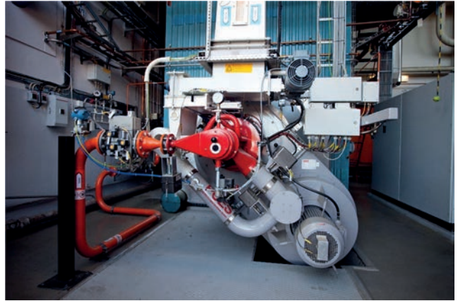
Biopoltin CTI asennuksesta.
