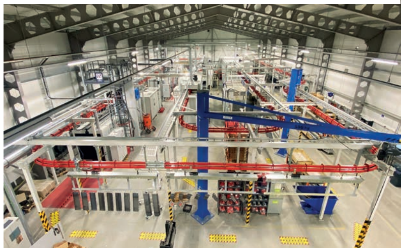
Spraytecin PP Maalaukselle toimittama tehokas, automaattinen kaksikerrospulverimaalauslinja on varustettu power & free -kuljetusradalla. Pintakäsittely valmistuu kertakierroksella ja tuotteet ovat jäähtymisen jälkeen heti pakattavissa.
