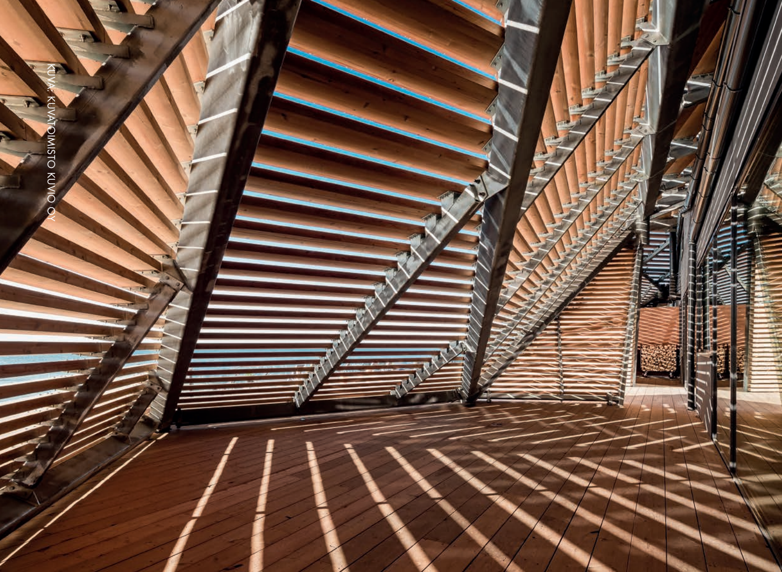
Puusäleikkö toimii rakenteellisena auringonsuojauksena. Kohde: Löyly, Avanto Arkkitehdit.
