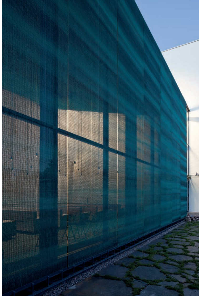
Auringonsuojaukseen on käytetty kupariverkkoa julkisivussa. Kohde: Pyhän Laurin kappeli, Avanto Arkkitehdit.
