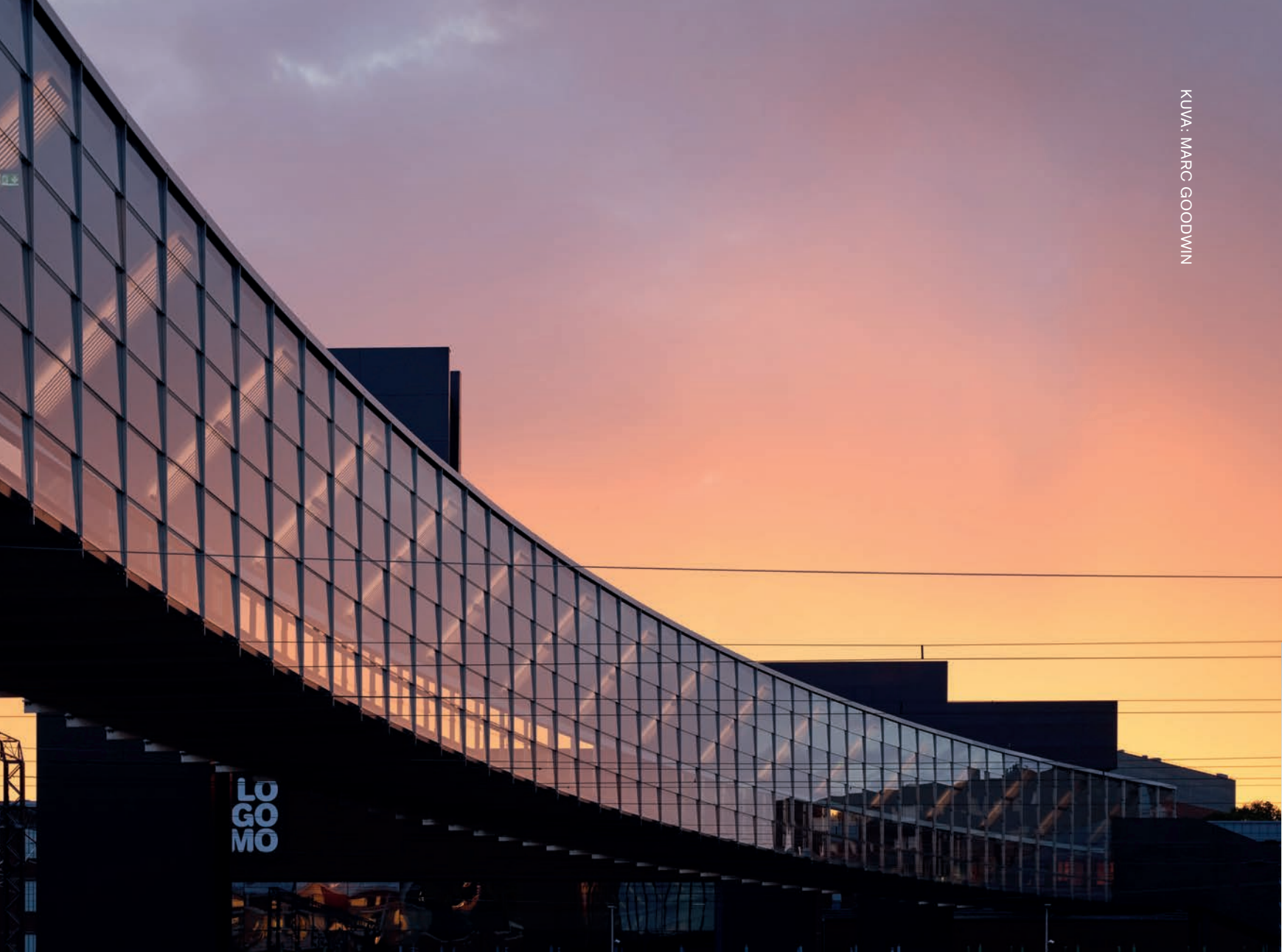
Logomon sillassa on käytetty itsepuhdistuvaa lasia.
