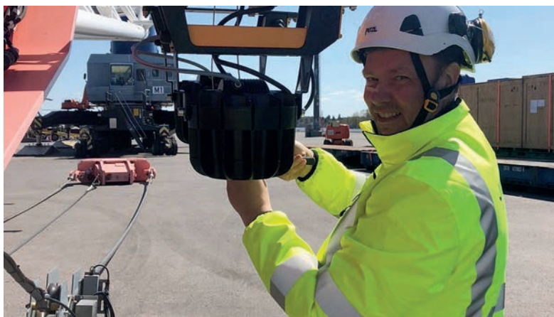
JUKO HT valaisimien asennus.
