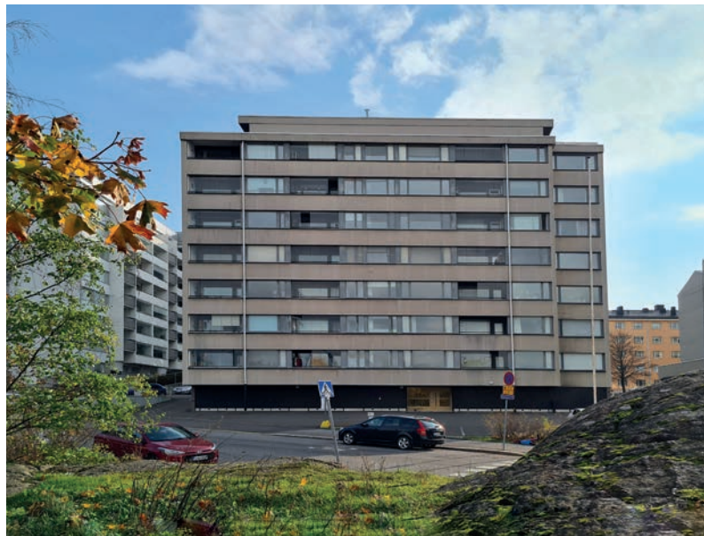
Helsingin Alppikadulla sijaitseva As.Oy Sopu hankki Smart Heatingin kiinteistöautomaatiolla ohjatun kokonaisjärjestelmän poistoilman lämmön talteenotolla, viilennyksellä ja kaukolämmöllä.
