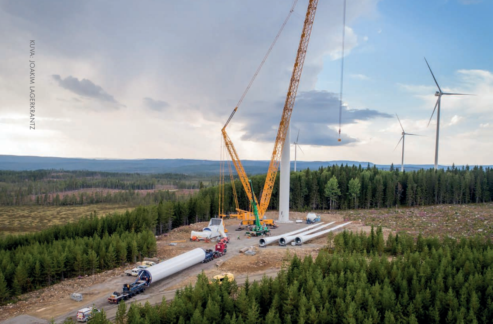
Tuulivoimalan asennus käynnissä.
