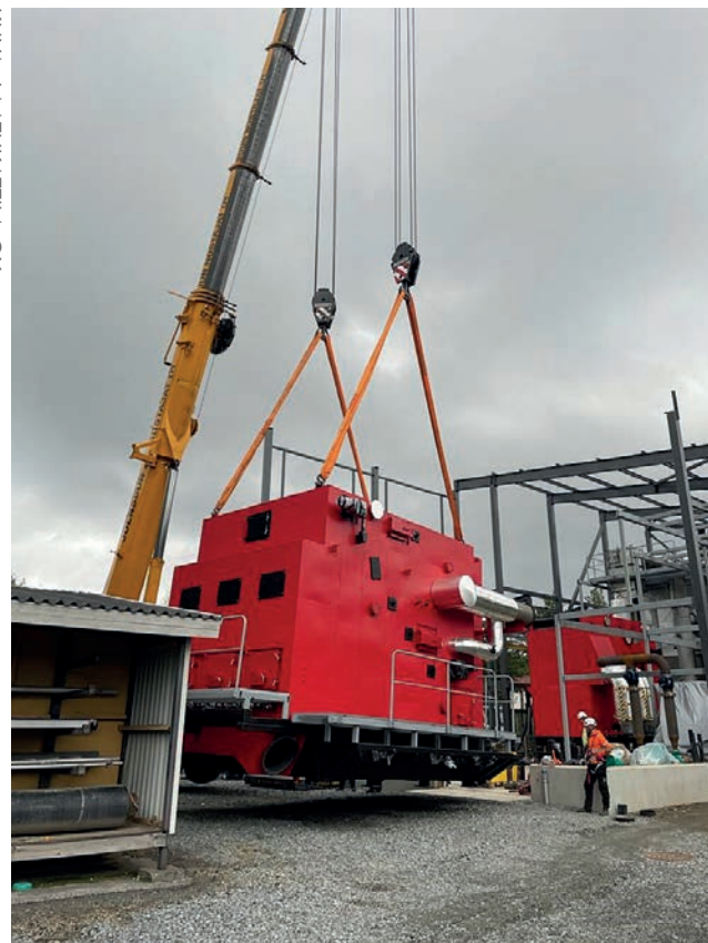
Kitee Arppe lämpölaitokseen kattilan Laka Y-5.5 MW asennus meneillään.
