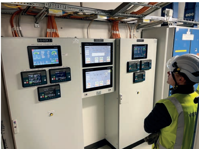
Varavoimajärjestelmän ohjauskeskukset.
