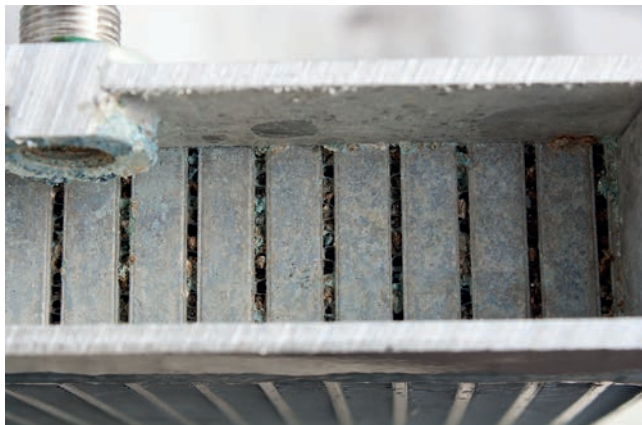
Kuvassa vasemmalla puhdistamaton jäähdytyskenno ja oikealla puhdistettu.
